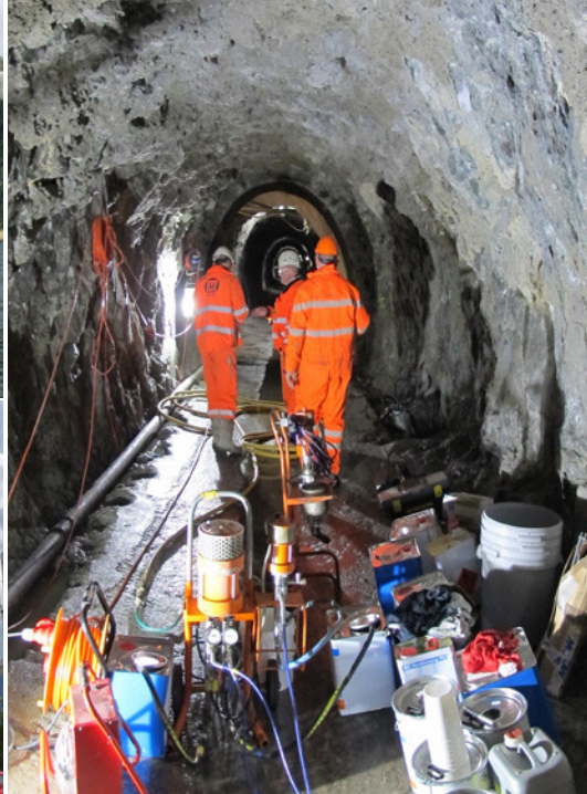
Auf Nummer sicher gingen Betreiber und Planer sowohl bei der Instandsetzung des riesigen Suschenskaja-Staudamms in Russland als auch bei der Beschichtung der Kühltürme des Kraftwerks Belchatov in Polen (Bilder links). MC-Know-how half auch, den Druckwasserstollen des Wasserkraftwerks Amsteg, Schweiz, wieder abzudichten (Bildmitte). Im Windpark nahe Trairi (Brasilien) kamen von den Fundamenten über die Verklebung von Betonteilen bis hin zur Beschichtung der Türme MC-Systeme zum Einsatz.
