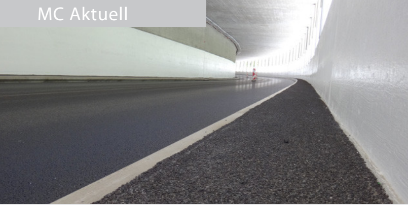
Bild links: Die Jordiguhittinigerie in Simplon, Schweiz, ist mit der Innenbeschichtung Emcephob HPC in RAL 9010 versehen worden. Bild rechts: Automatisierte Beschichtungsarbeiten in der Schallbettgalerie durch die Firma Trauffer AG, Brienz.
