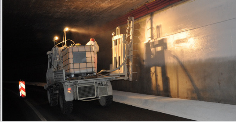
Bild links: Die Jordiguhittinigerie in Simplon, Schweiz, ist mit der Innenbeschichtung Emcephob HPC in RAL 9010 versehen worden. Bild rechts: Automatisierte Beschichtungsarbeiten in der Schallbettgalerie durch die Firma Trauffer AG, Brienz.
