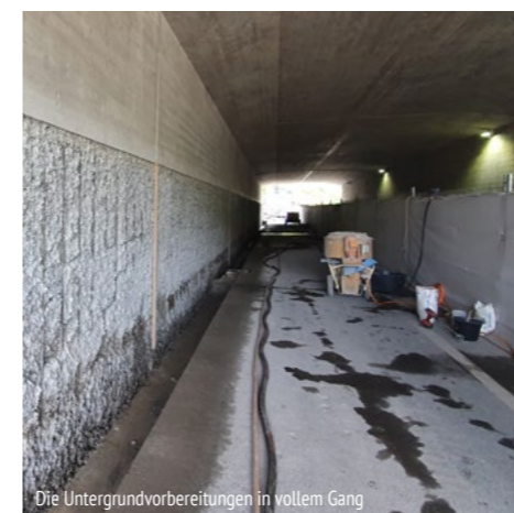
Die Untergrundvorbereitungen in vollem Gang
