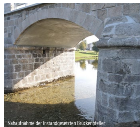
Nahaufnahme der instandgesetzten Brückenpfeiler
