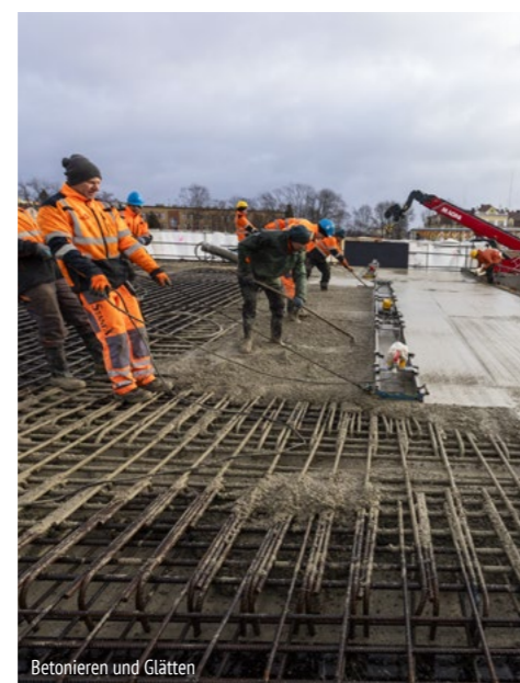
Betonieren und Glätten
