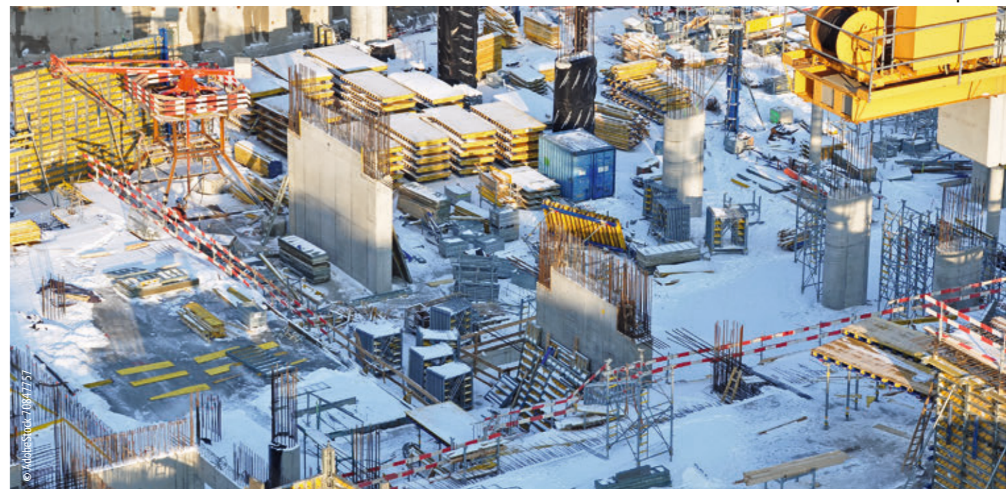
MC-FastKick bietet auch im Winterbau viele Vorteile: neben einer spürbaren Verflüssigung und Konsistenzverweigerung auch eine sehr starke Beschleunigungswirkung sowie schnellere Aushärtung als mit konventionellen Betonrezepturen.
