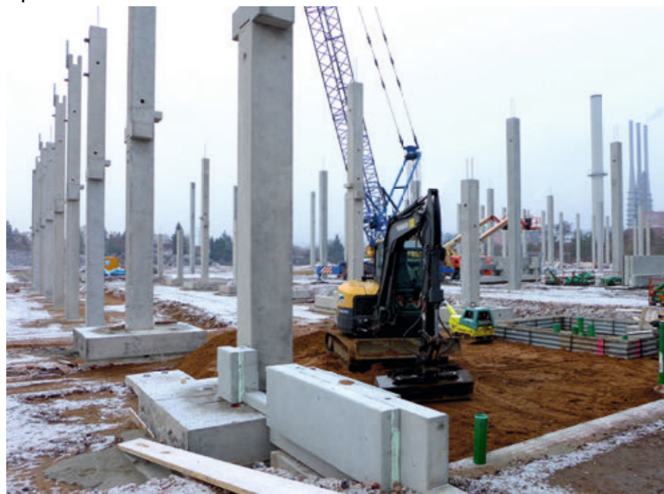
Erhärtungsbeschleuniger sorgen auch im Winterbau für hohe Frühfestigkeiten und kürzere Aushärtungszeiten.
