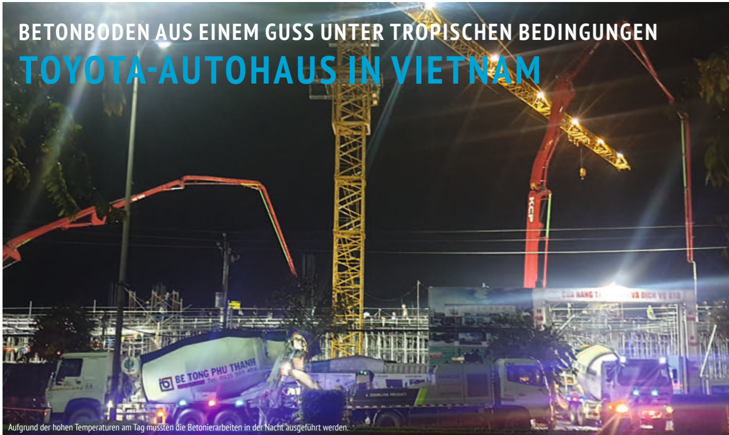
Aufgrund der hohen Temperaturen am Tag mussten die Betonierarbeiten in der Nacht ausgeführt werden.
